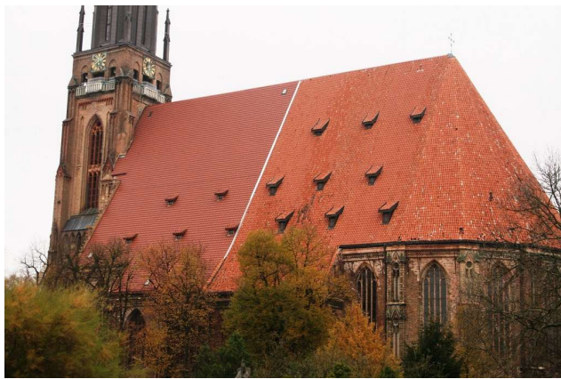
Das teilweise erneuerte Dach
